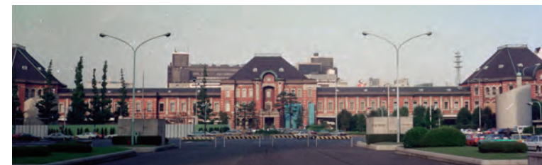
整備前：車道照明が東京駅を覆っていた
