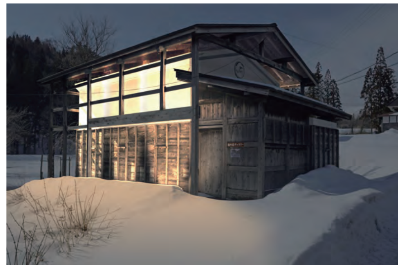
土蔵は軒下からのアップライトで壁面を照らす。軒が深いため器具が雪で埋まらない
