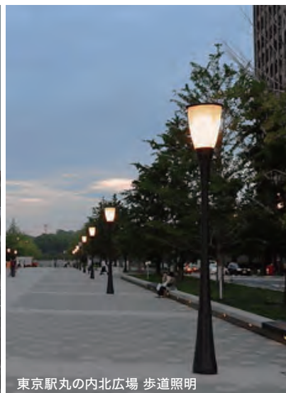
東京駅丸の内北広場 歩道照明
