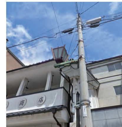
電柱共架タイプ・・・2 基
