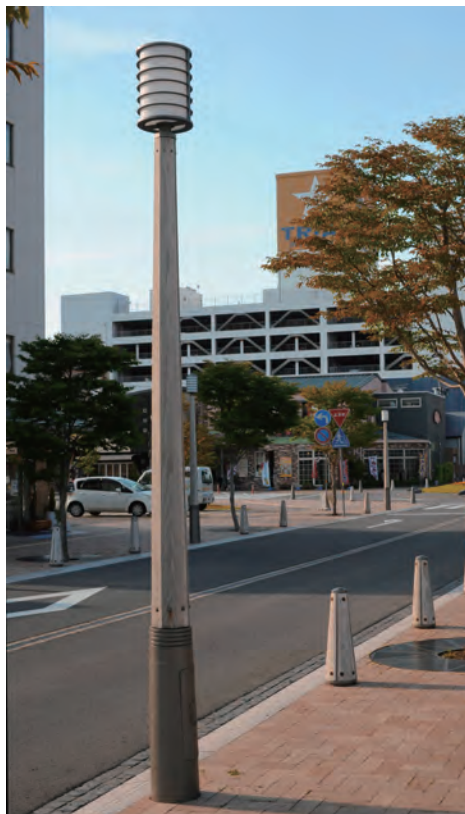
街路照明は心棒として鋼管を使用 基壇は鋳鉄 灯具はガラス + アルミ 鋳物
