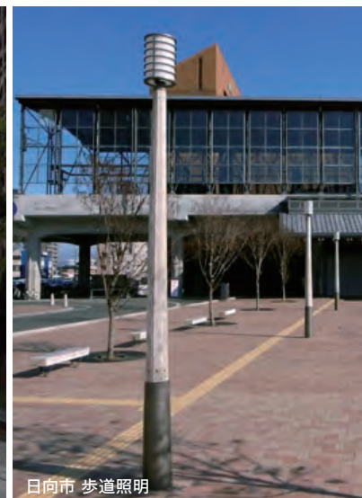
日向市 歩道照明
