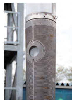
支柱は鋳鉄 自動点滅器内蔵
