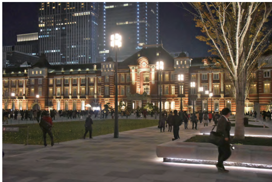
駅舎のライトアップと共に駅舎を引き立てるポール照明、加えて樹木のライトアップ、ベンチ下部のフットライトなど相乗的に空間の演出を行っている：東京駅丸の内駅前広場
