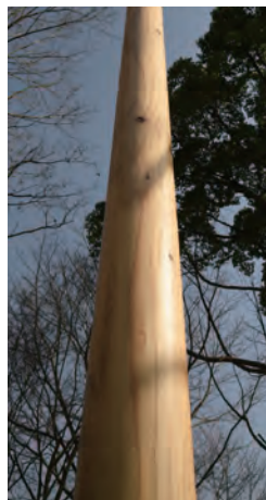
木柱見上げ 丸太をくり抜き、鋼管を通して
